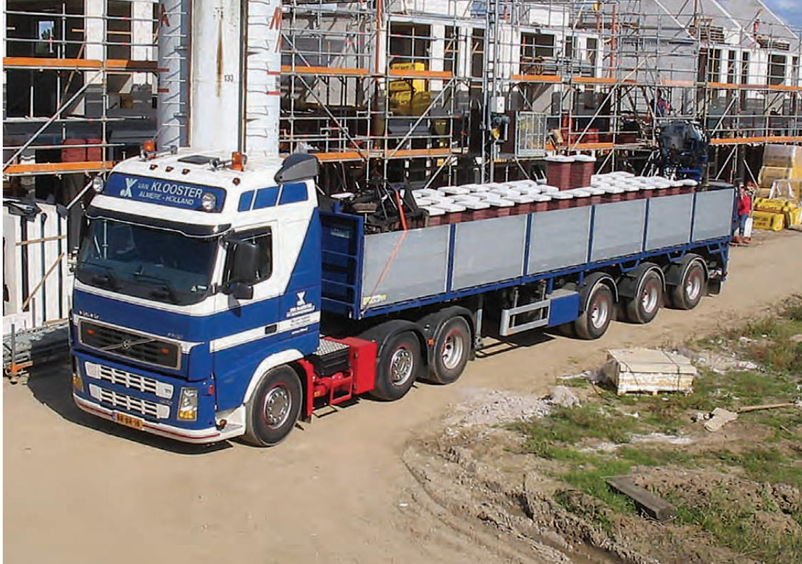
Lossen op de bouwplaats.
